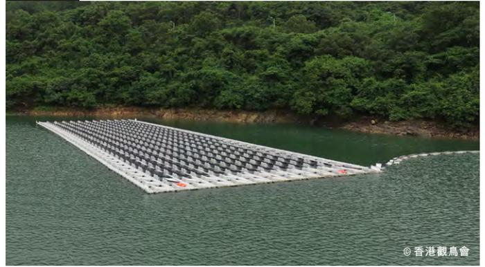
水務署於2017年分別在石壁水塘（左圖）和船灣淡水湖安裝小型浮動太陽能板發電系統作為先導計劃，以研究在水塘推行大型浮動太陽能發電場的可能性<sup>173</sup>。
